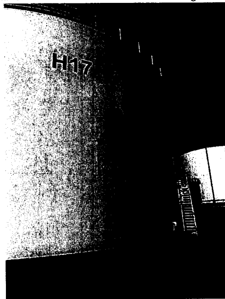
Mynd 4. Viða hefur málning verið slípuð í burt, bert stálið hefur tærst með tímanum en óverulegt.
